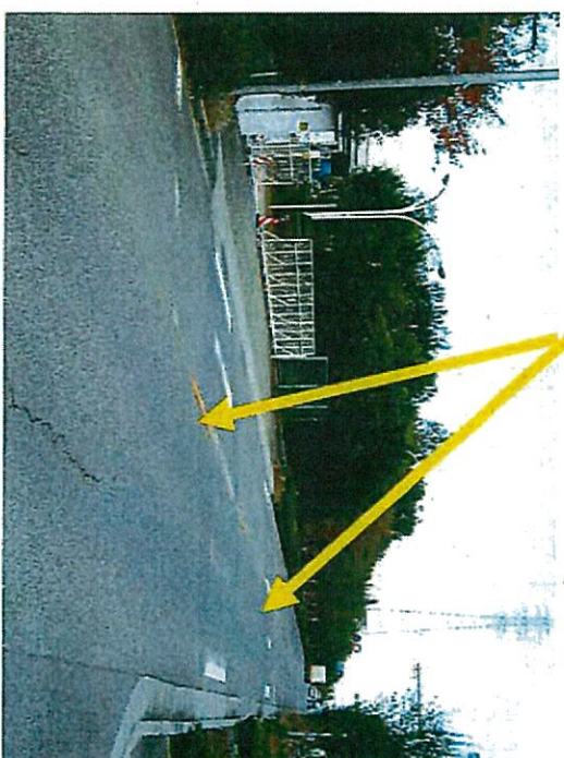
⑩横断歩道・停止線が消えている
